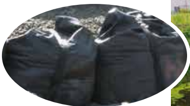
ここの改修工事 (仮の土のう4段積み)
