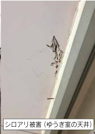
シロアリ被害 (ゆうぎ室の窓枠)
