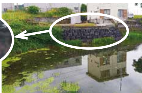
ここの改修工事 (仮の土のう4段積み)
