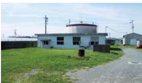
建て替えを予定している西古泉水源地
