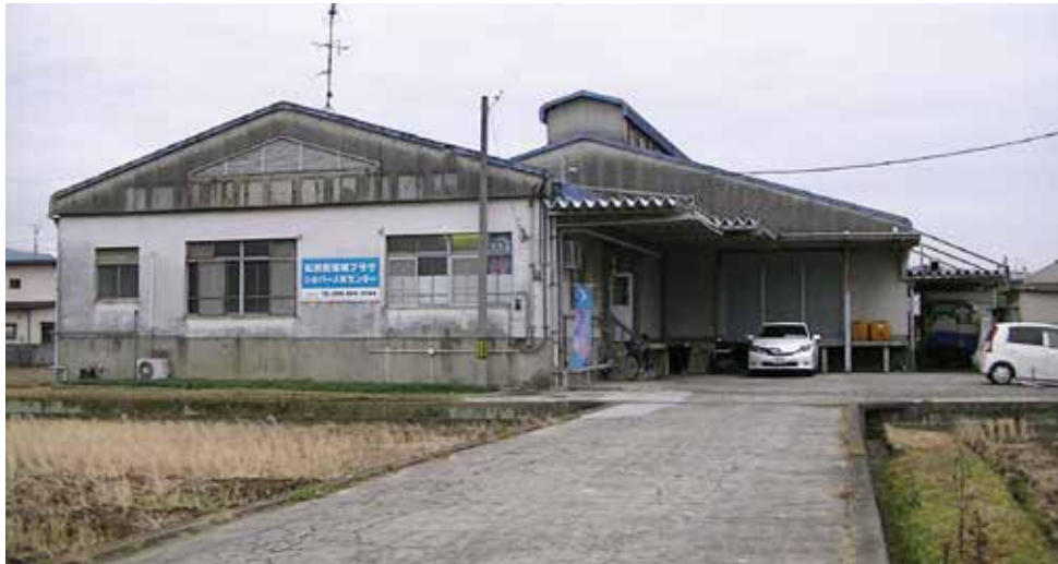
取りこわしが予定されている松前町環境プラザ（シルバー人材センター）
