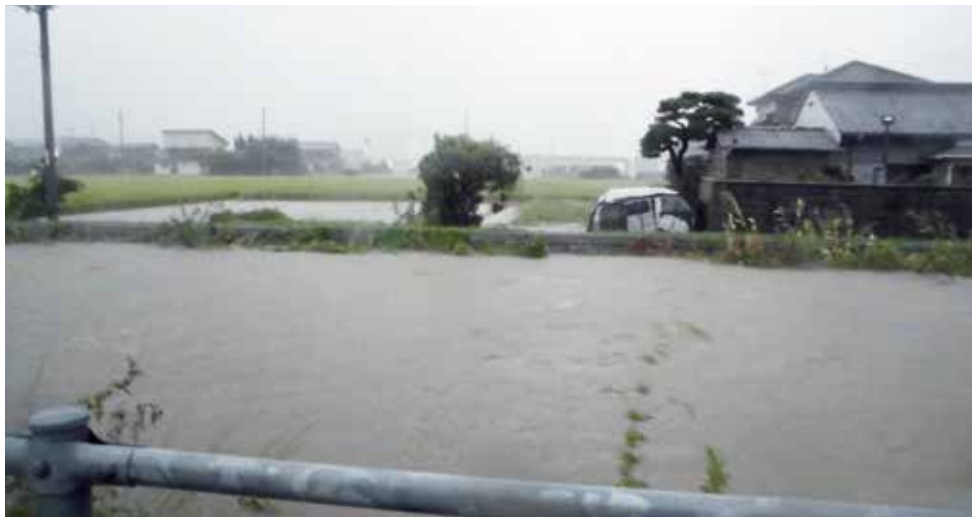
台風18号 長尾谷川（松前中学校上流） いすい 溢水寸前か！
