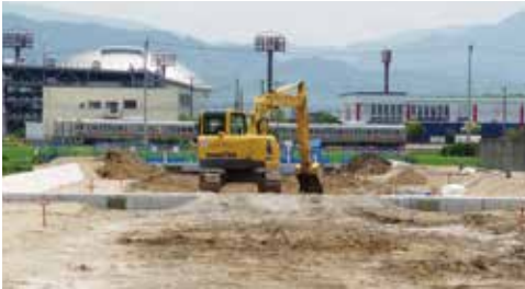
工事は順調に進んでいるのだが？
