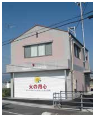
第4分団消防詰所
