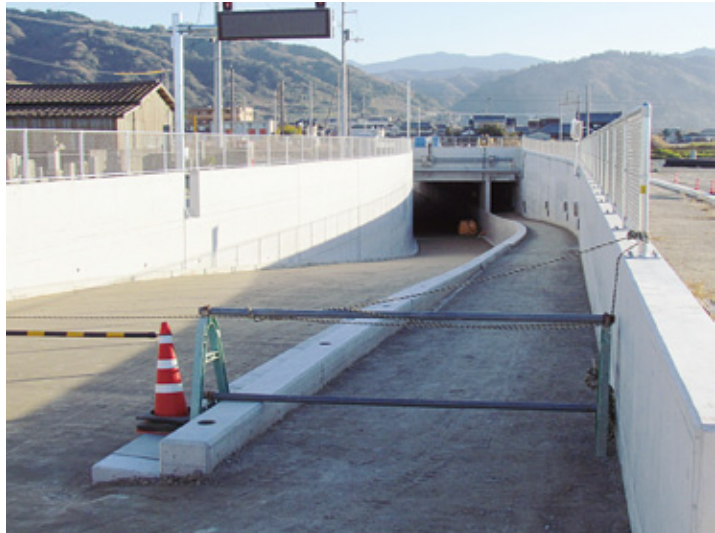
町道東44号線地下道の整備状況
