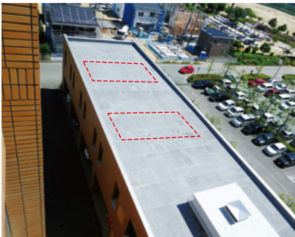
車庫棟屋上に太陽光パネルの設置
