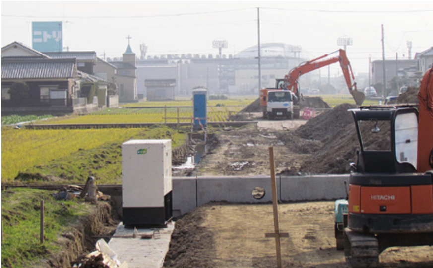
町道西古泉筒井線 道路整備スタート
