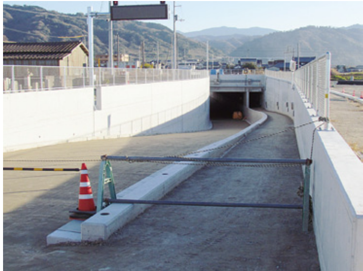
町道東44号線地下道の整備状況
