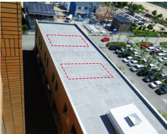
車庫棟屋上に太陽光パネルの設置
