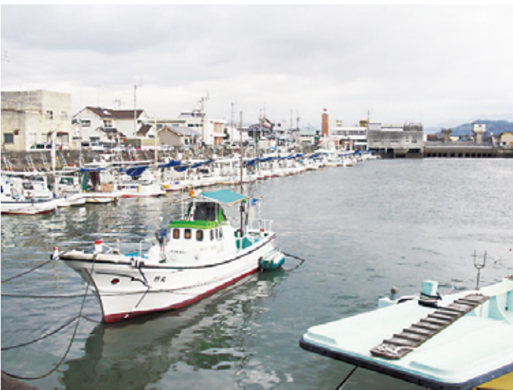
岸壁改良で港の利便性アップを
