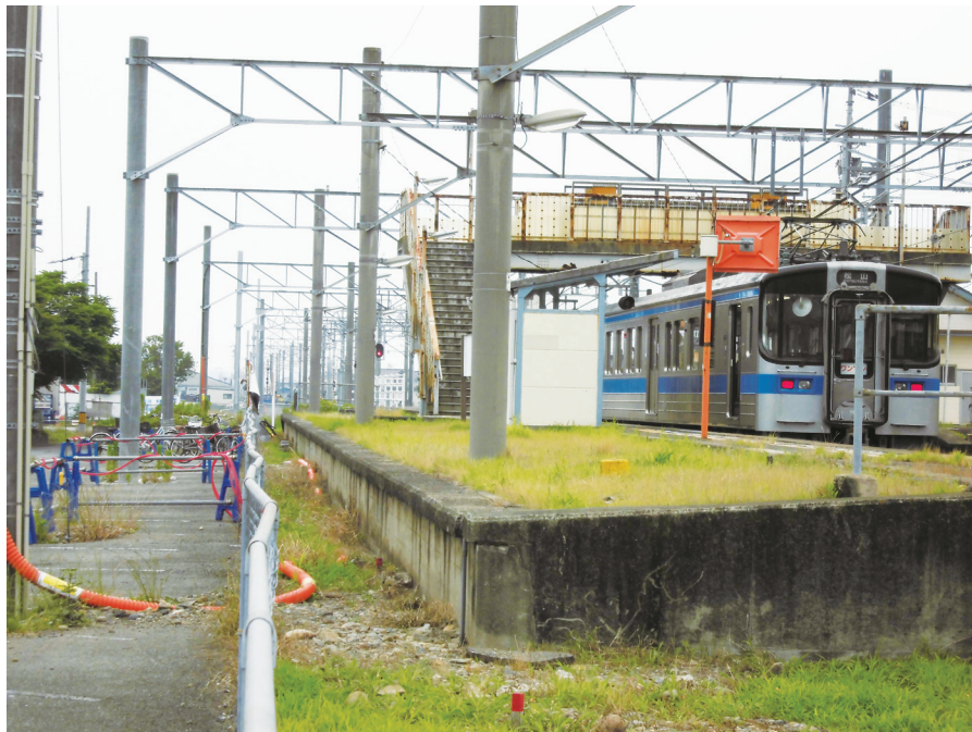
工事中の3番線路と北伊予駅高架橋
