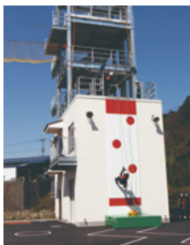
新しくなった消防署施設(砥部町)
