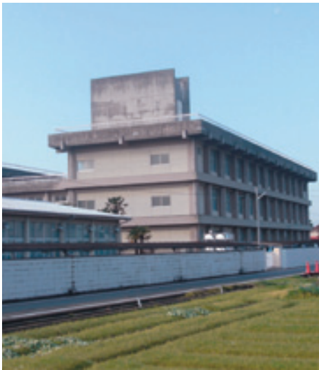
耐震工事が始まる北伊予中学校
