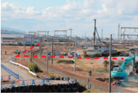
ホッケー場水道管整備工事場所
