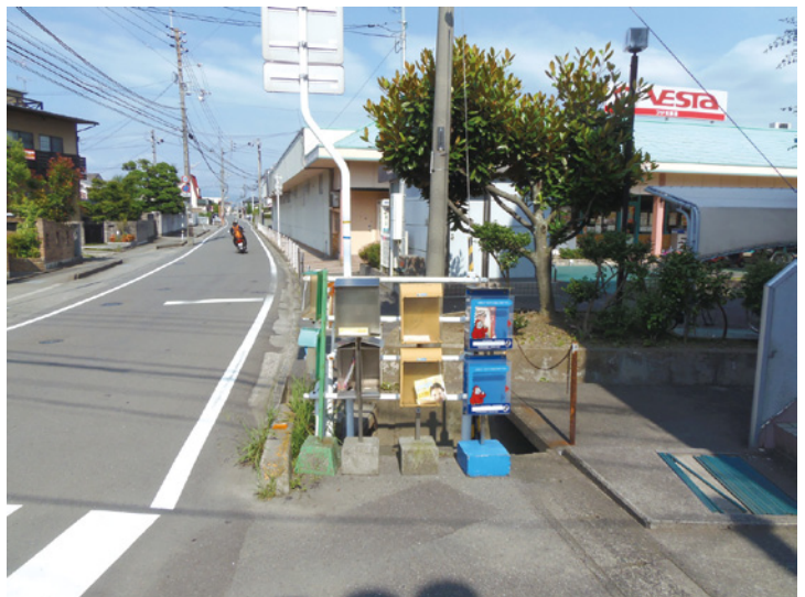
危険な水路、早急な整備を！
