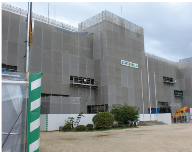
耐震化工事中の岡田小学校校舎
