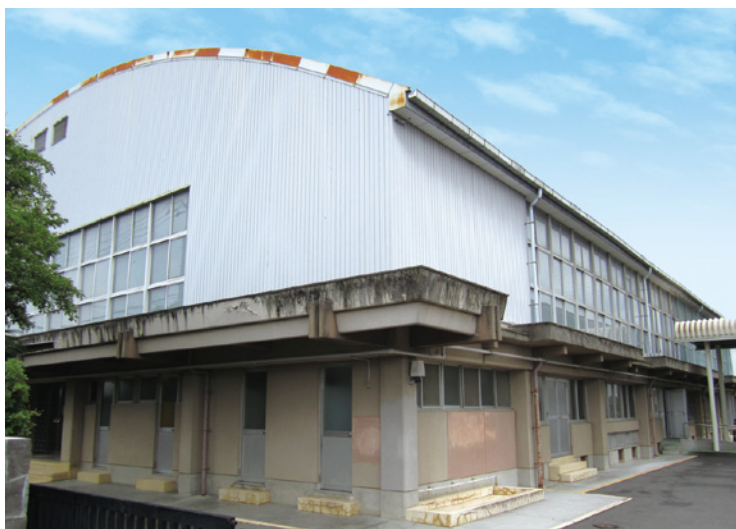
耐震補強工事予定の岡田中学校体育館
