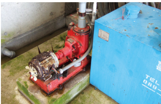
改修されるポンプ(松前町漁協)
