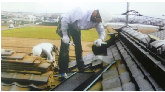
西古泉公民館雨漏り修理工事
