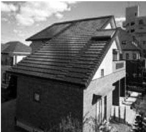
住宅用太陽光発電はエコです！！
