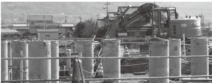
徳丸浄水場（建設中）
