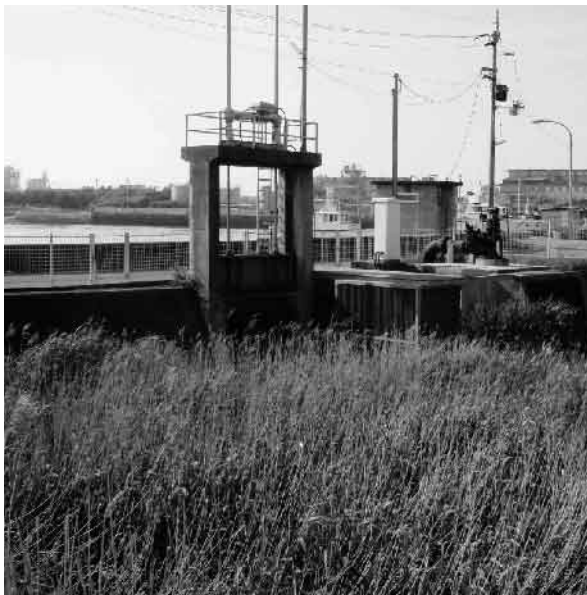
江川雨水排水ポンプ取替
