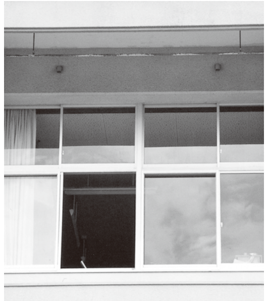
大丈夫ですか校舎窓ガラス
