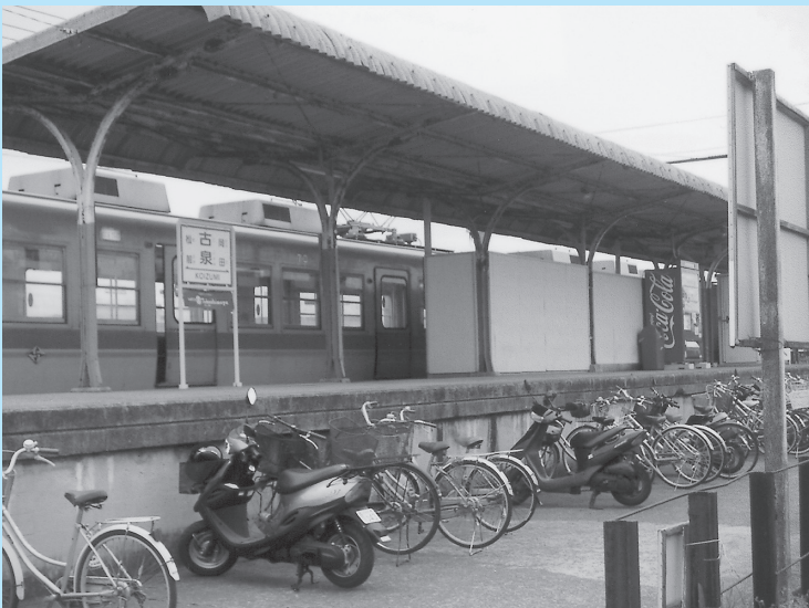
古泉駅改修(バリアフリー化)
