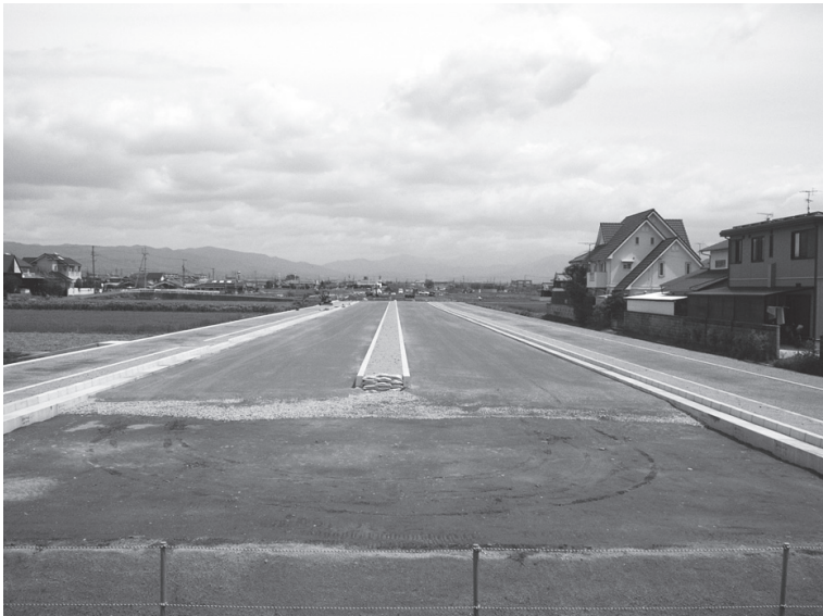
町道筒井徳丸線道路新設
