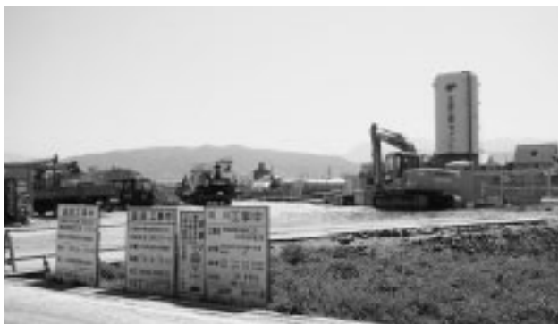
筒井徳丸線工事現場
