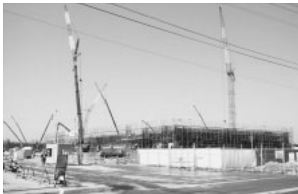
東レ工事現場
