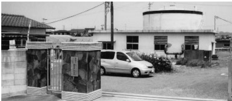
西古泉水源地
