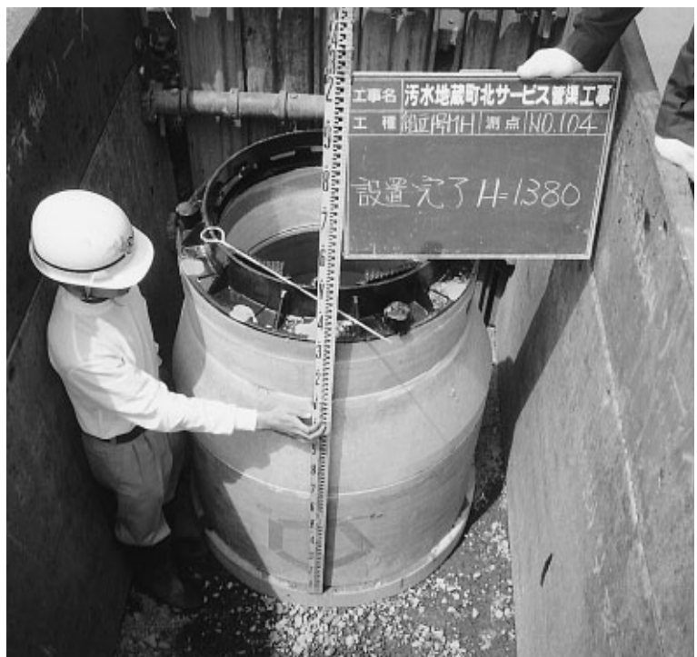
公共下水道工事
