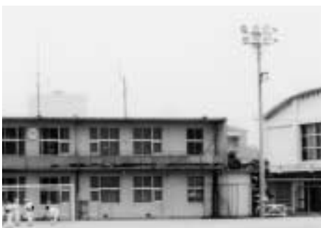
松前中学校夜間照明
