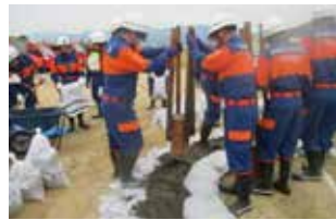
土のうを積み重ねていぼうの決かいをふせぐための工事の様子
