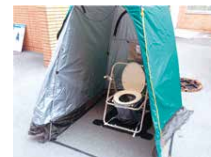
マンホール直結式トイレ (出典：広ほうまさき2014年11月)
