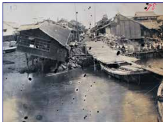
風水害 台風による夫婦橋流出 1943(昭和18)年7月(松前町) (出典:愛媛県)
