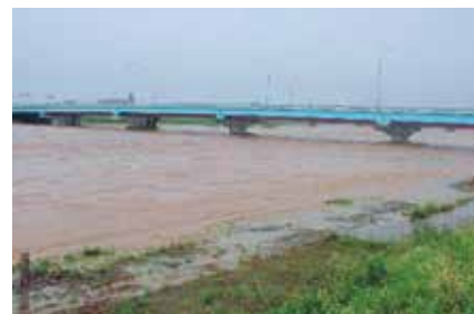
出合橋の様子
