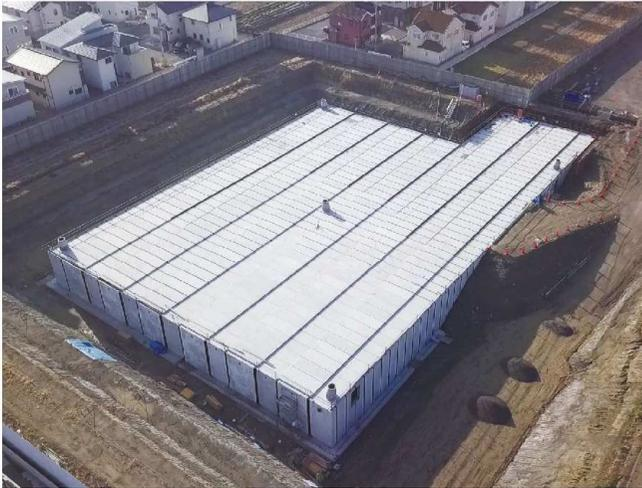
施工事例(貯留容量10,000m<sup>3</sup>)
