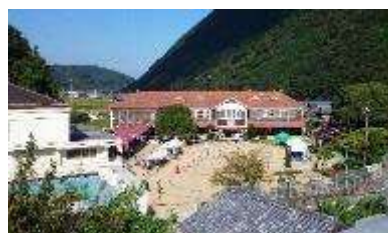
翠小学校の木造校舎
