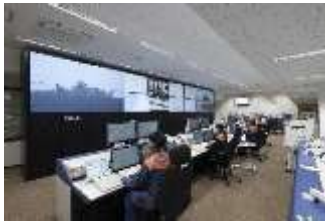
松山圏域消防指令センター
